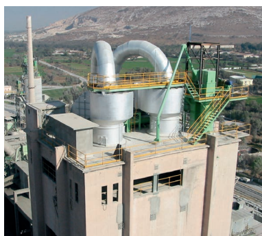
HOLCIM APASCO, Mexiko Zementwerk
