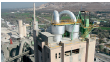
HOLCIM APASCO, Mexiko Cement Plant
